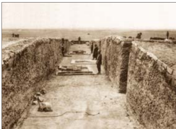
地下墓室宮、部屋Ⅱ (左)、墓Ⅳの入口 (中央) および内部 (右)
