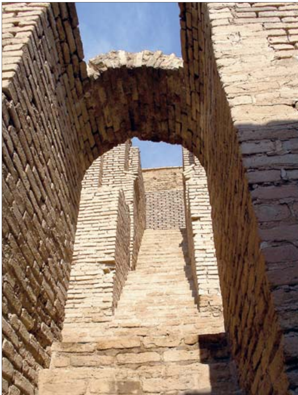
ジググラトの南西部階段上の丸天井 Vault above the southwest stairway of the ziggurat طاق پلکان جنوب غرب زیکورت
